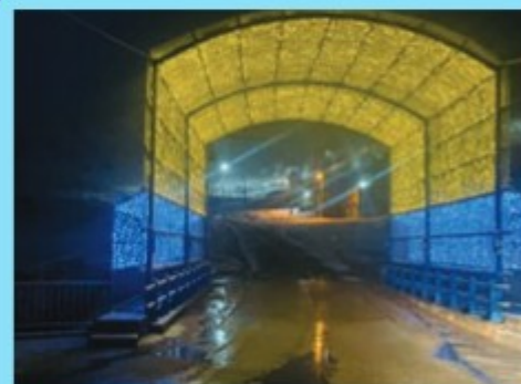
۱. احداث تونل نوری روی رودخانه ليله
