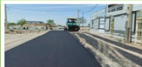
عملیات زیرسازی و آسفالت معابر منتهی به خیابان شیخ بهایی
