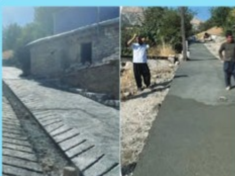
۵. بتن‌ریزی معابر سطح شهر
