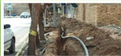
اجرای خط لوله آبیاری خیابان دکتر بهشتی
