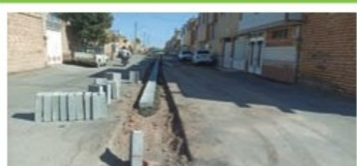
اجرای کانپو و آسفالت خیابان قائم
