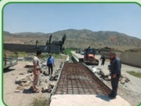
عملیات اجرای کانال و پوشش آن
