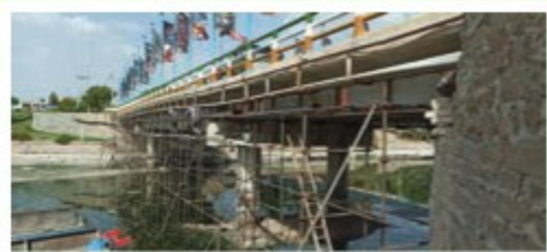
اجرای خط لوله ۲۰۰ فولادی پل شهید مطهری
