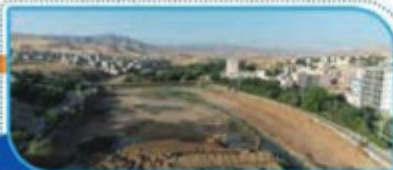
عملیات اجرایی و ساماندهی فاز ۲ و رودخانه سقز
