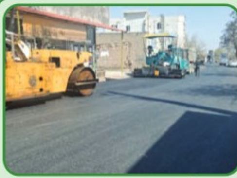
اجرای آسفالت ریزی و روکش معابر اصلی و فرعی سطح شهر
