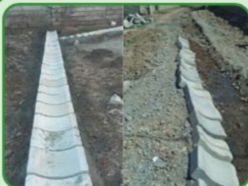
اجرای کانپو، آبرو و جوی آب
