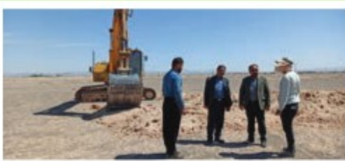
عملیات خاکبرداری معابر فاز دوم نهضت مسکن ملی
