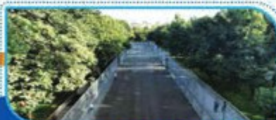
عملیات اجرایی احداث گذر ورزش و نصب بیش از ۲۰ ست ورزشی و بازی در پارک مولوی کرد
