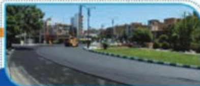
اجرای نهضت آسفالت در سطح شهر با آسفالت و لکه گیری بالغ بر یک میلیون و دویست هزار متر مربع از معابر سطح شهر
