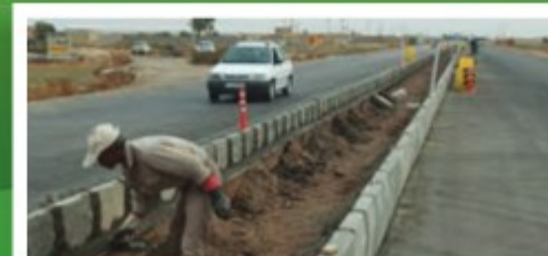
پروژه احداث بلوار آزادگان
