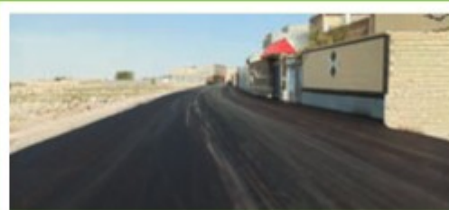
زیرسازی و آسفالت کوچه فضیلت و حقیقت در بافت قدیم شهر
