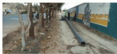
اجرای خط لوله ۲۰۰ میلی متر خیابان رسالت و امام خمینی
